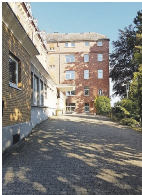
Auf dem Gelände des Pflegezentrums St. Joseph in Moresnet werden vier betreute Wohnungen fertiggestellt.
